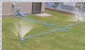
ミロスプリンクラーによる漏水
